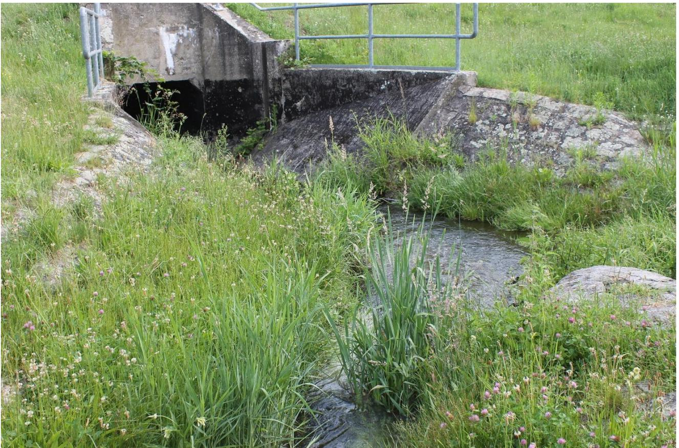
Der Zschampert unterquert den Elster-Saale-Kanal sieben Meter unter dessen Wasserspiegel in einem Tunnel. Foto: Birgit Peil – NABU Sachsen
