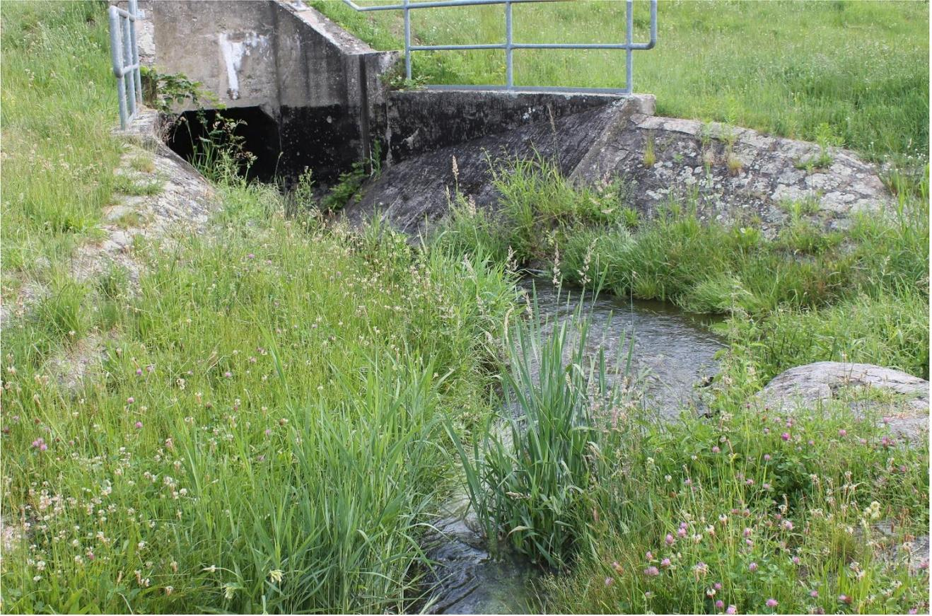
Der Zschampert unterquert den Elster-Saale-Kanal sieben Meter unter dessen Wasserspiegel in einem Tunnel. Foto: Birgit Peil
